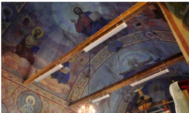
St Nikolay Mirikliiski Chudotvorec / Chelopech, Bulharsko Vysokoteplotní sálavé topné panely ECOSUN S+
